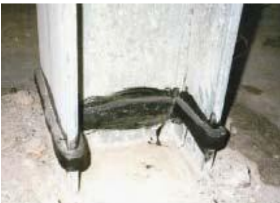
Lắp đặt Contite waterstop xung quanh trụ chính
