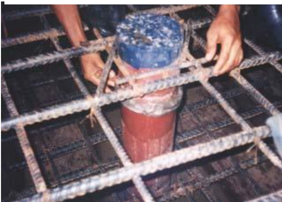
Lắp đặt Contite Waterstop xung quanh ống
