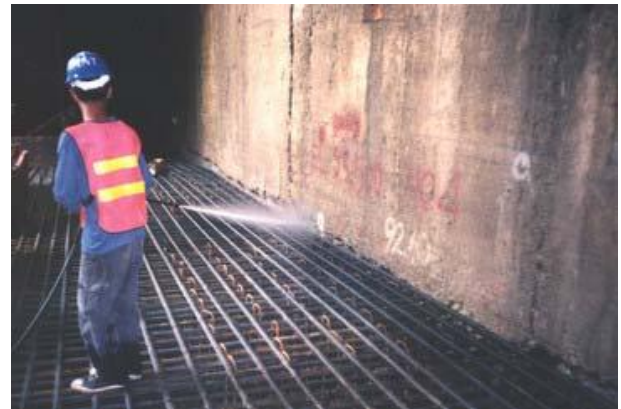
Làm sạch bề mặt bằng cách xịt nước.
