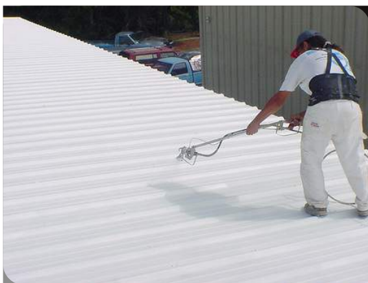
Thi công bằng phương pháp phun
