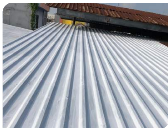
Thi công quét lót lót
