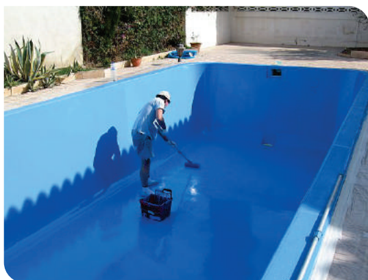
Thi công lớp 2
