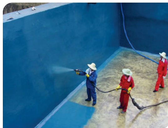
Thi công lớp 1
