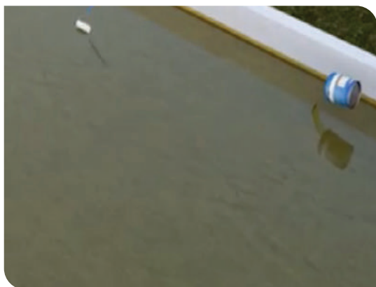
Thi công lớp lót
