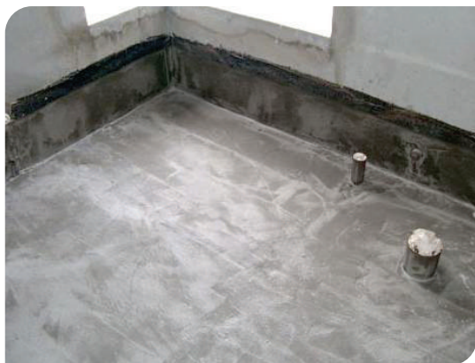
Vệ sinh xịt rửa bề mặt
