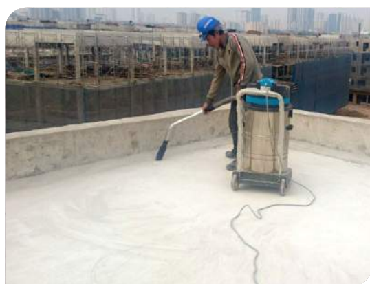
Vệ sinh chuẩn bị bề mặt
