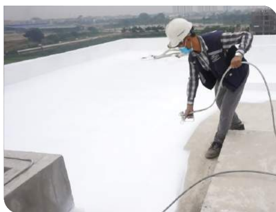
Thi công bằng máy phun
