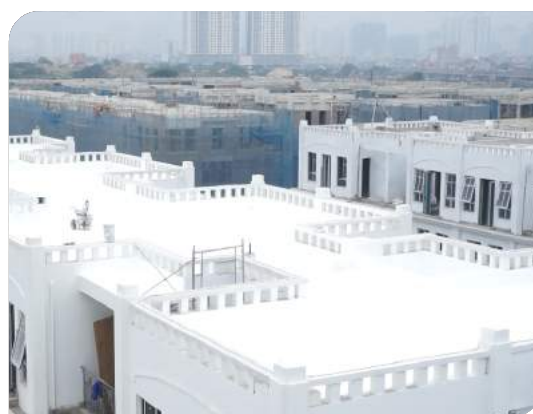
Bề mặt hoàn thiện
