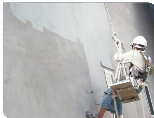
Thi công lăn Silatex ® Reflect
